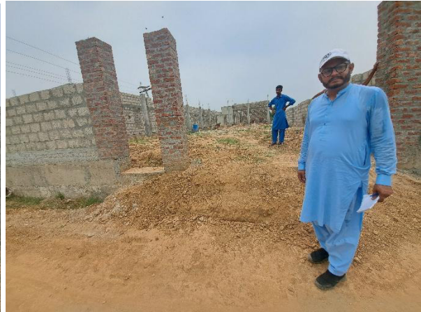
im Juni mit Bauleiter
